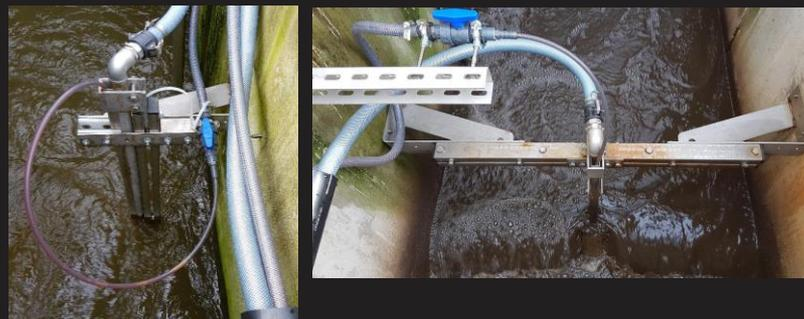
Abbildung 2: ecowirls zur Zwei-Punkt-Phosphatfällung im laufenden Betrieb
