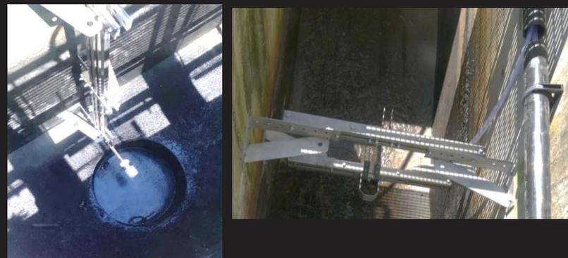
Abbildung 1: Installation von ecowirl und Halterung im Eingang zur Biologie und im Kanal im Zulauf zur Nachklärung
